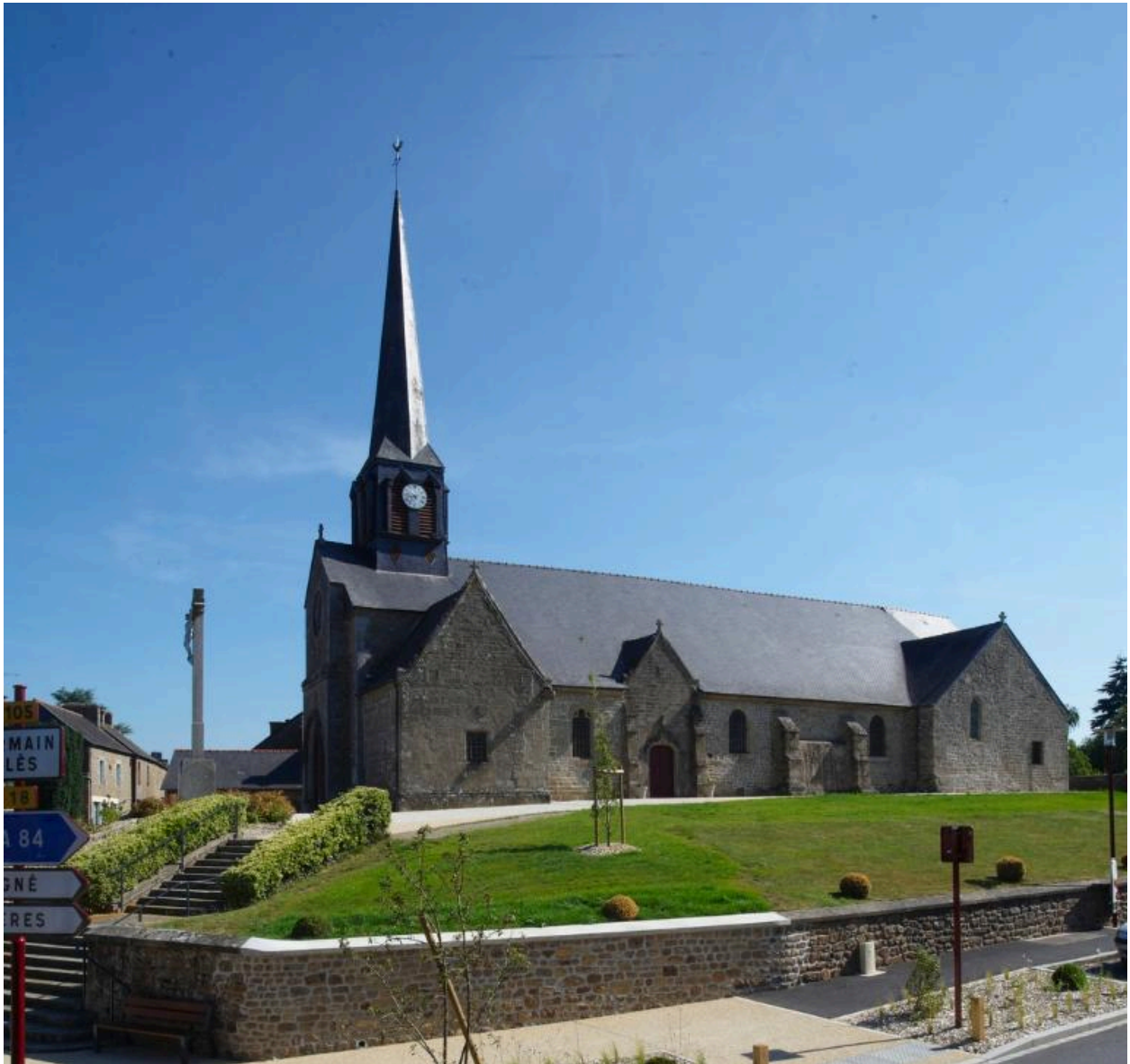
Élévation Sud : vue générale
