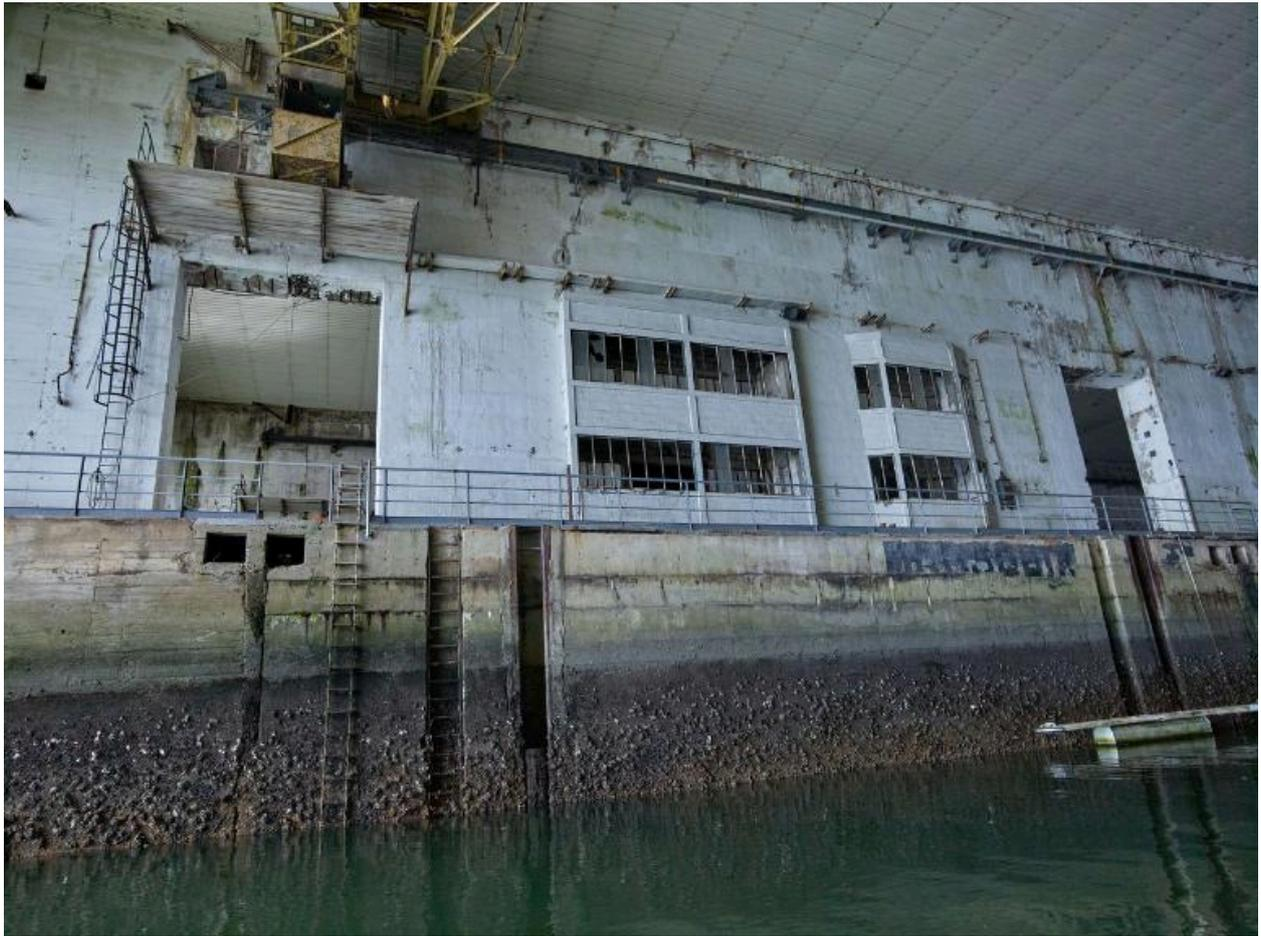
Vue de l'alvéole D : quai ouest n° 20. Dans l'épaisseur du mur de refend entre les alvéoles C et D se trouvent les salles des pompes d'épuisement et d'assèchement
