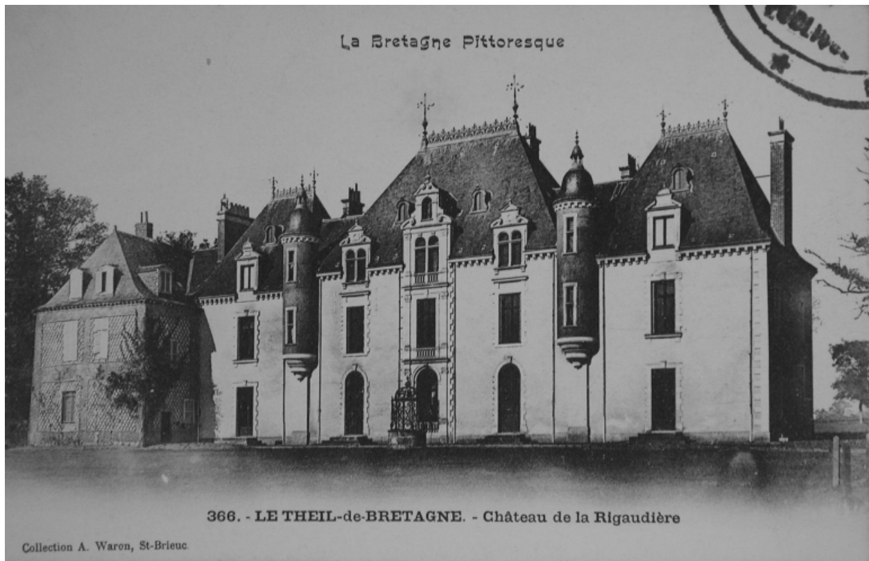
Vue générale de la façade principale au début du 20e siècle
