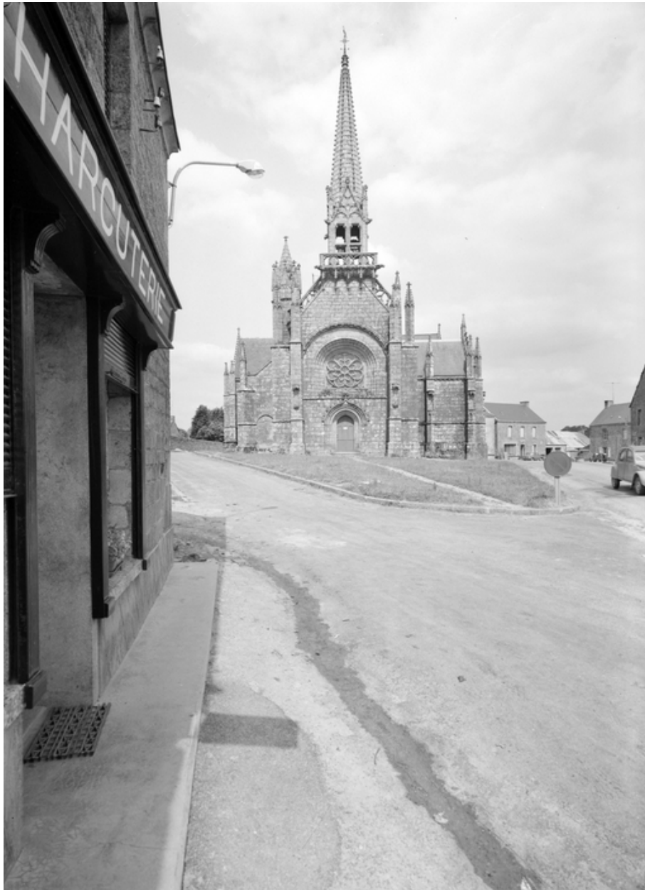
Vue générale éloigné depuis l'ouest
