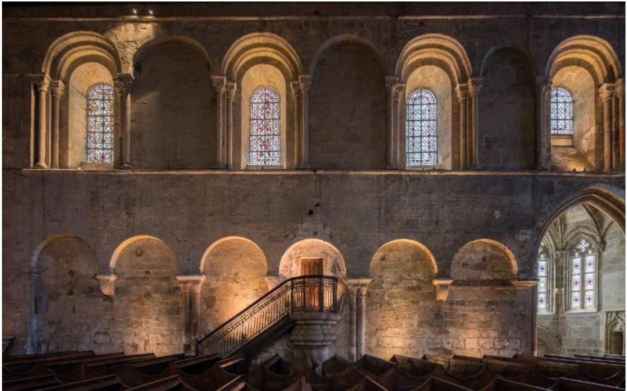
Intérieur vue du mur sud de la nef en 2019
