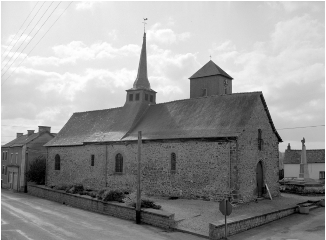
Elévation Nord : vue générale
