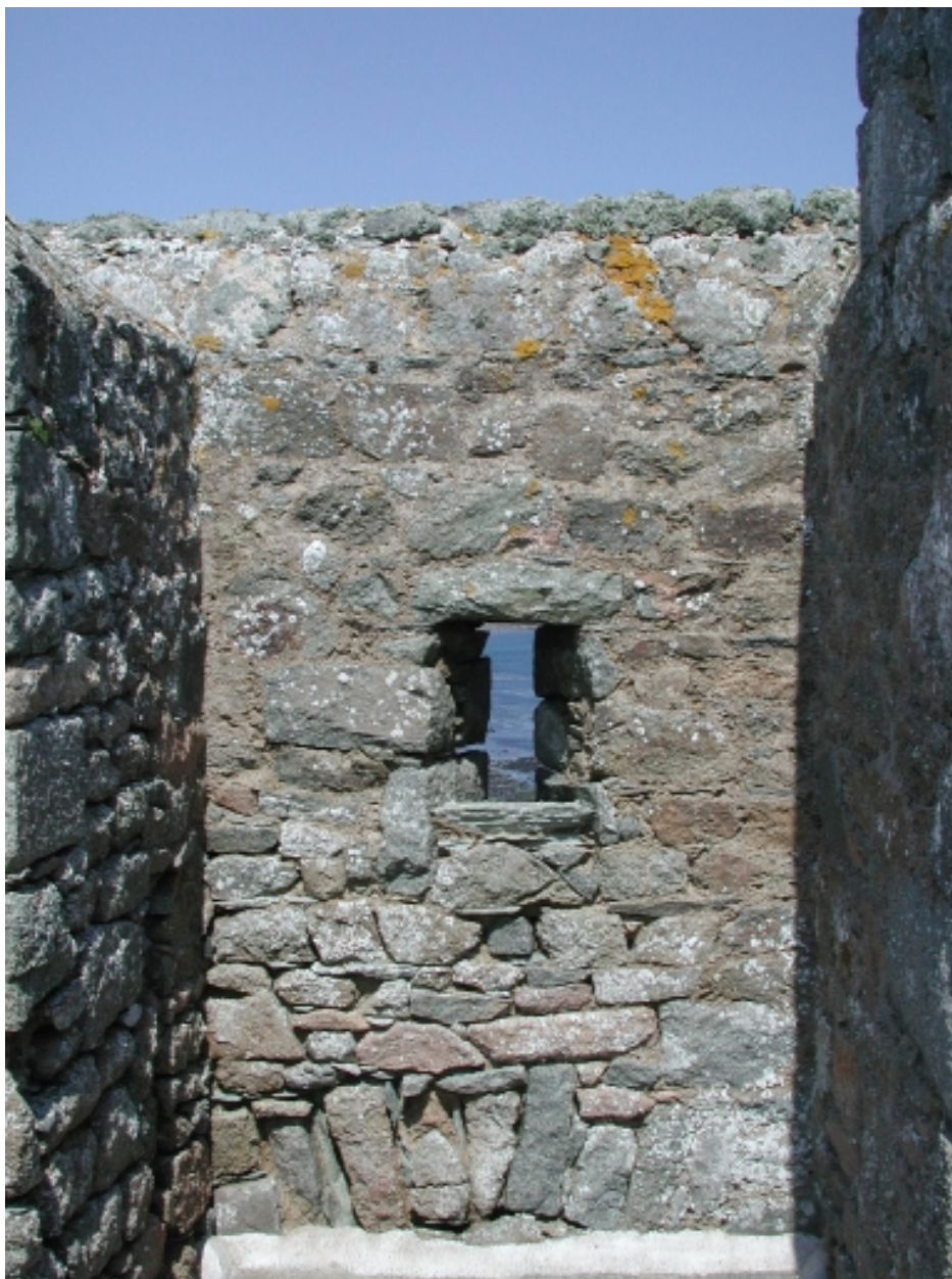
Meurtrière de la terrasse côté nord
