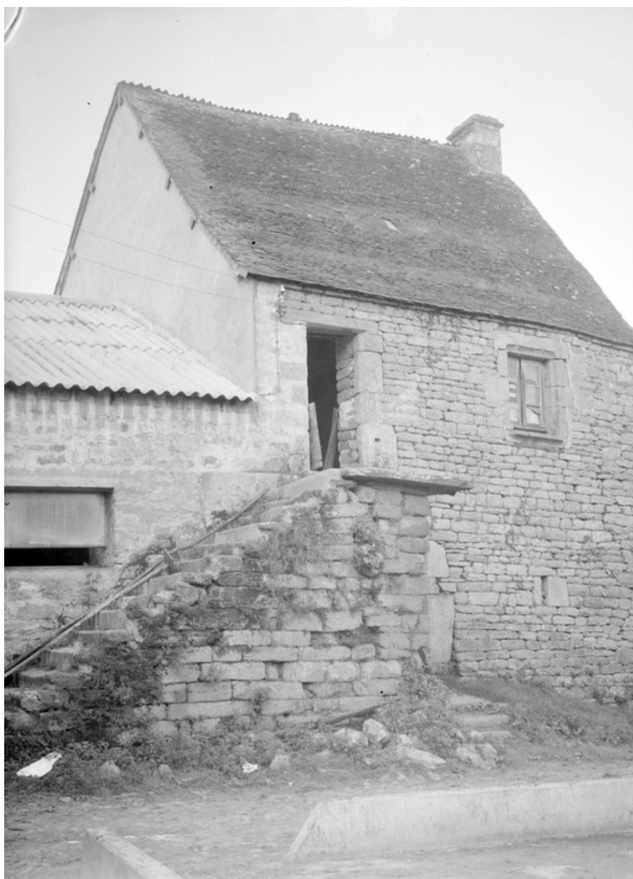
Vue d'ensemble de la façade est
