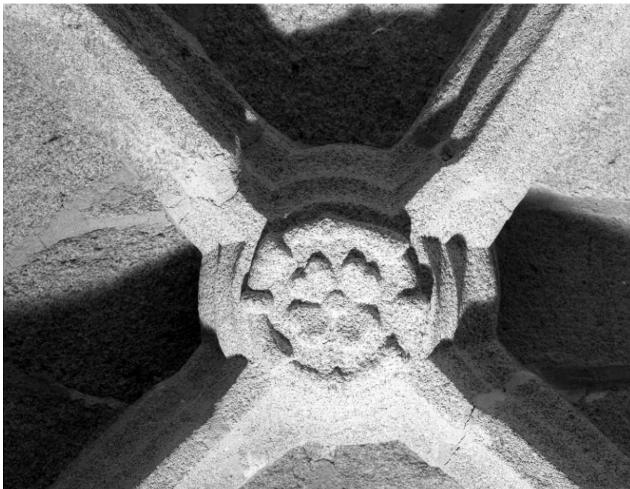
Escalier, 3ème repos du rez-de-chaussée : détail de la clé de voûte
