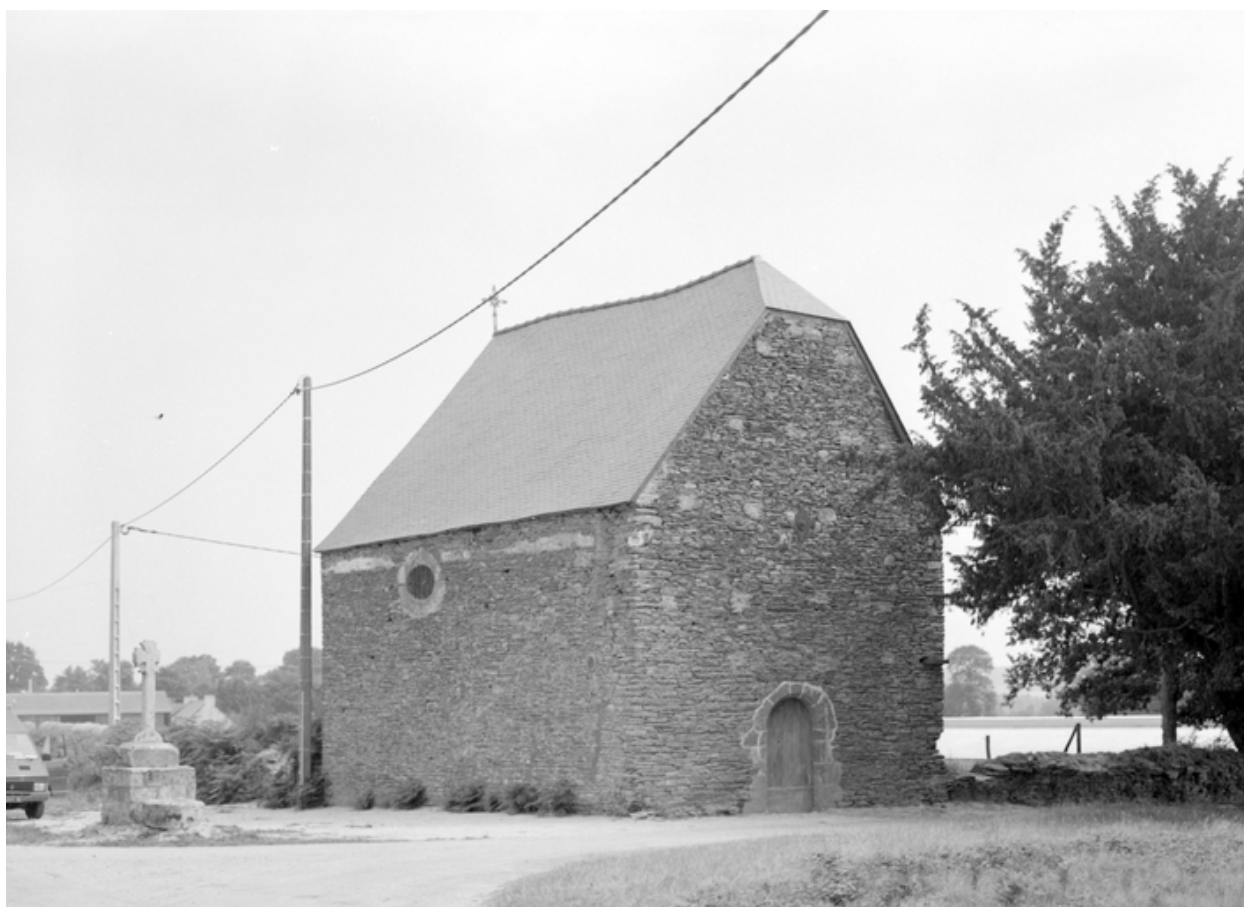
Chapelle vue nord-ouest (état en 1984)
