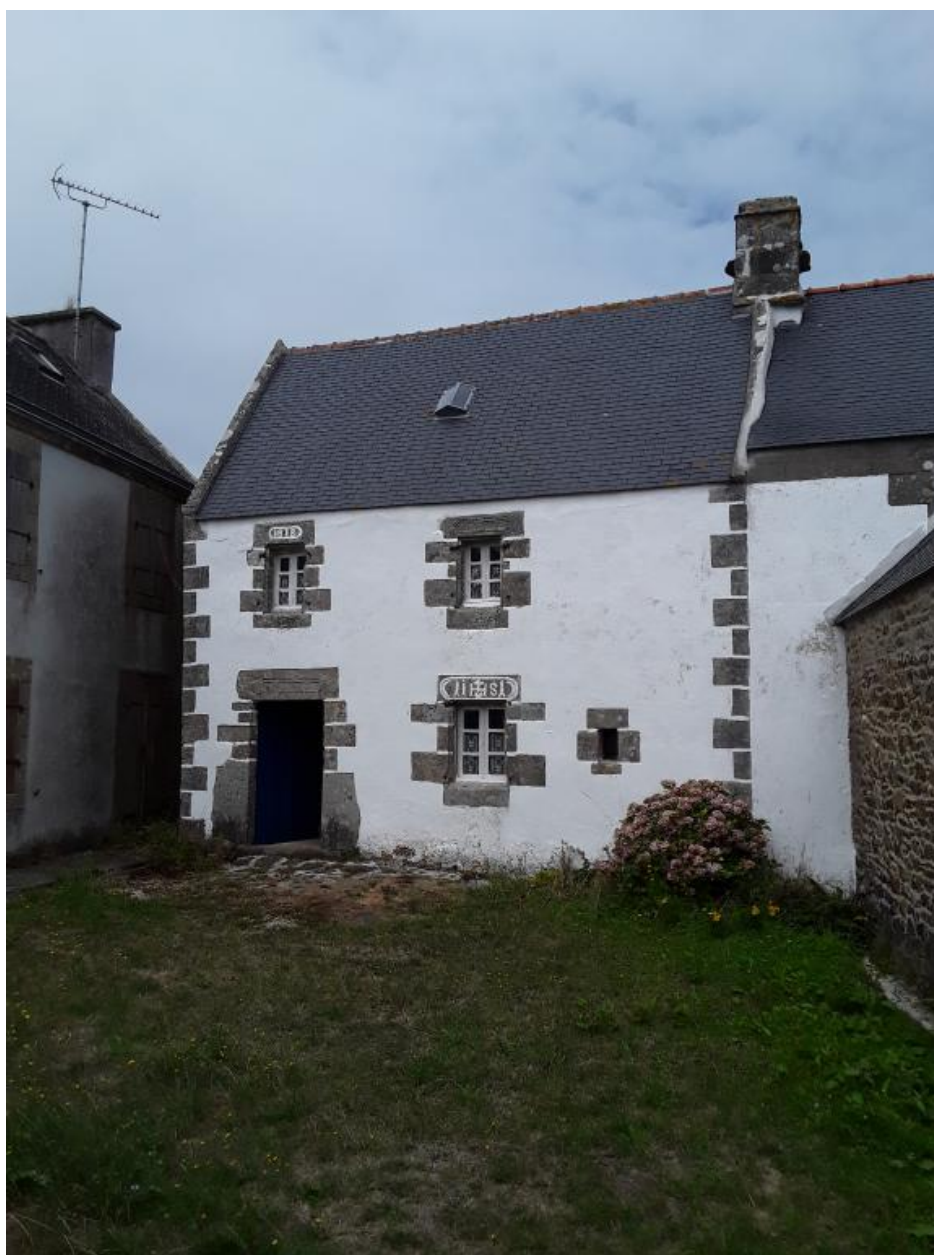
Maison 1 datée 1818, élévation antérieure. (2018)
