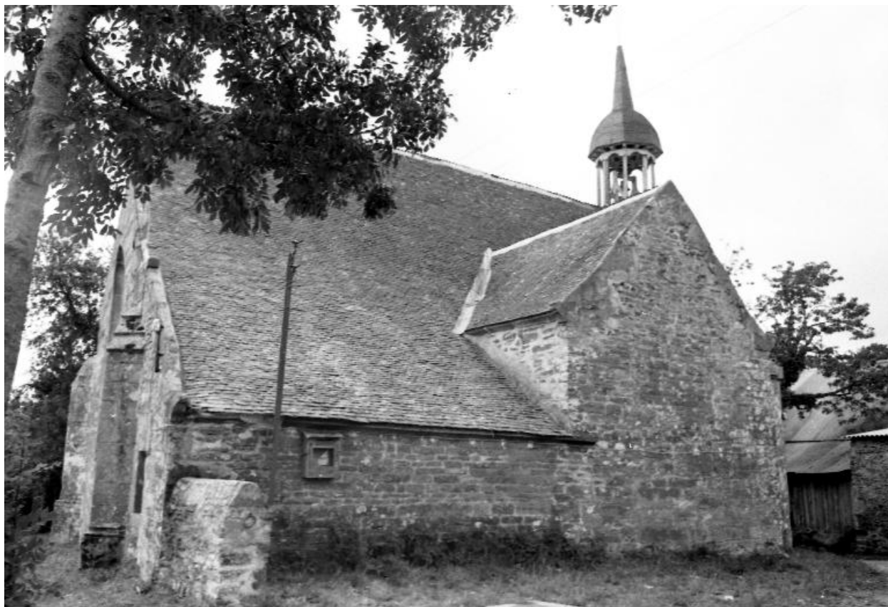
Vue d'ensemble de la façade nord.
