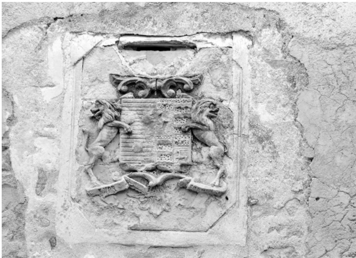
Chapelle : élévation intérieure nord : écu.
