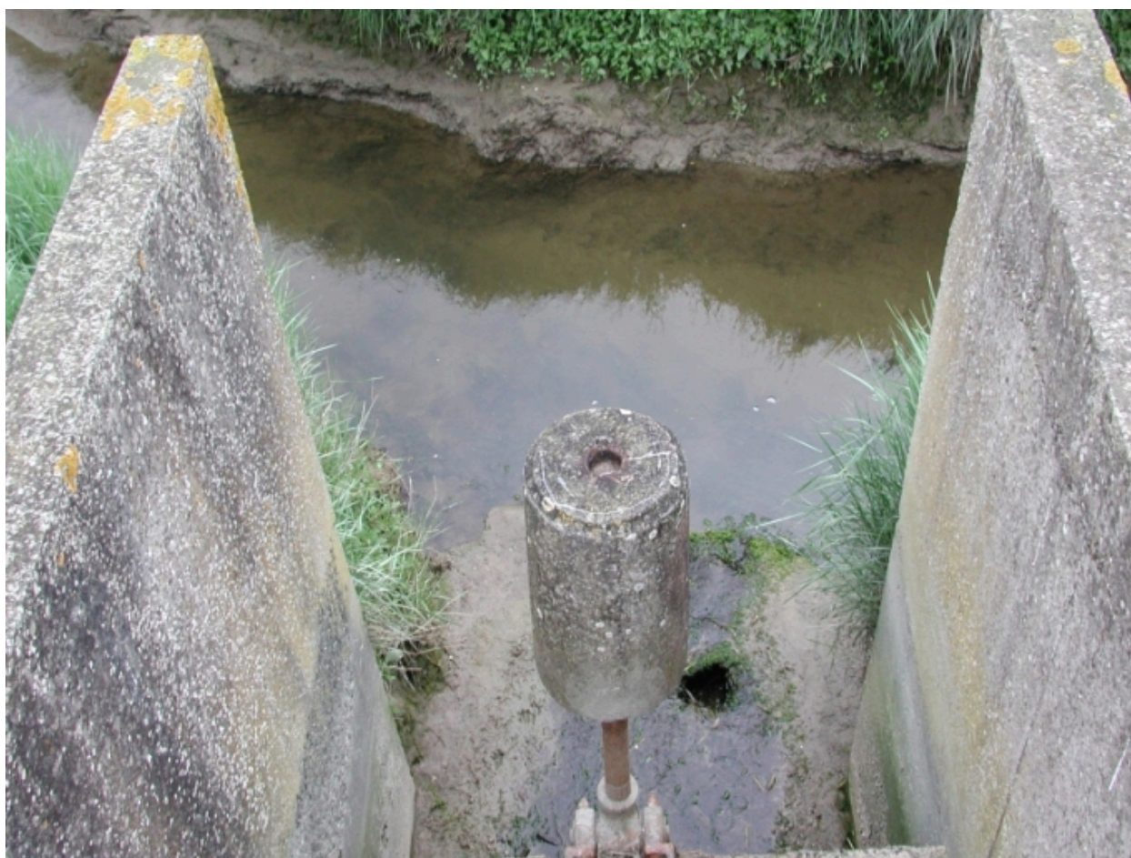
Ecluse : porte à marée du saint-Jean avec son contre-poids
