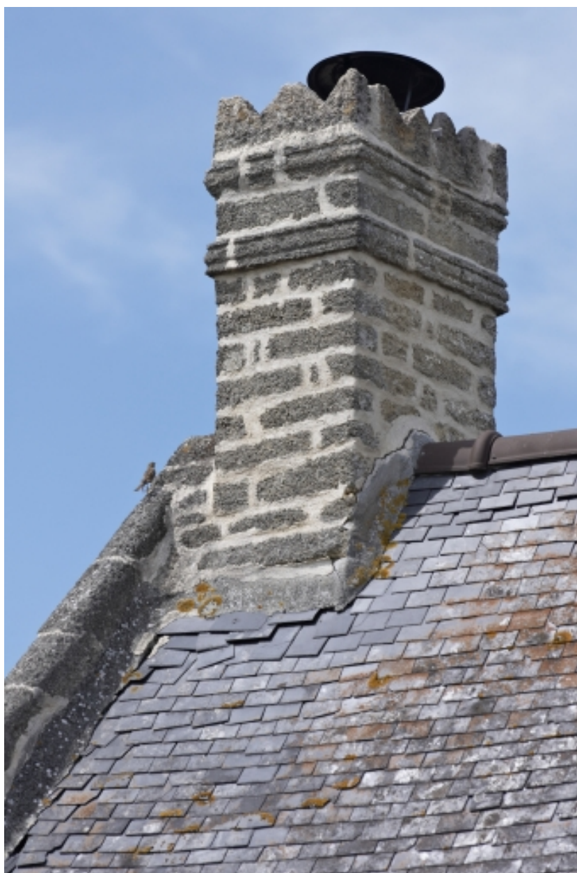
Détail : souche de cheminée
