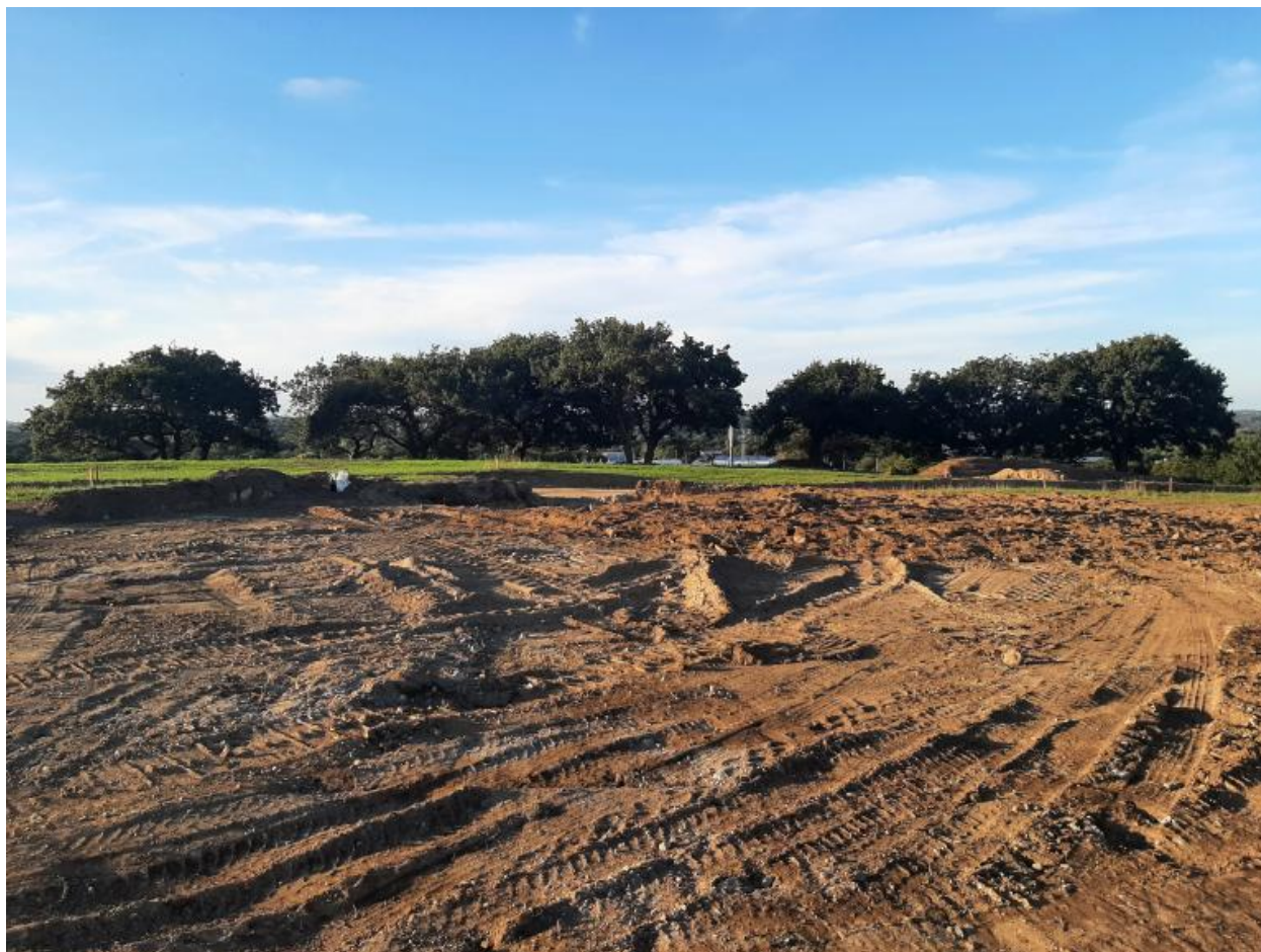
Vue générale après la déconstruction (11 octobre 2022)
