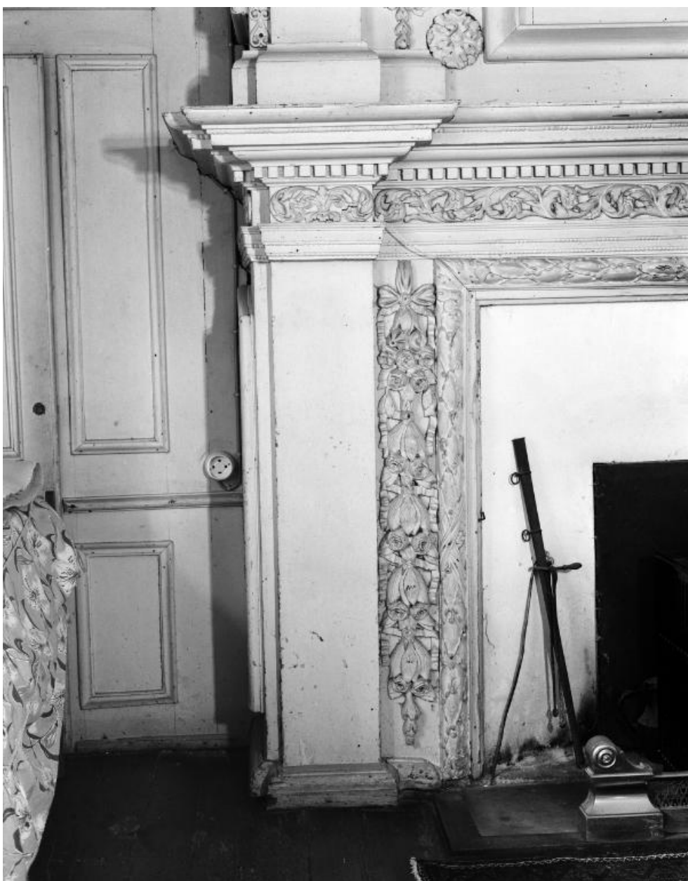
Corps central, étage, cheminée, détail piédroit
