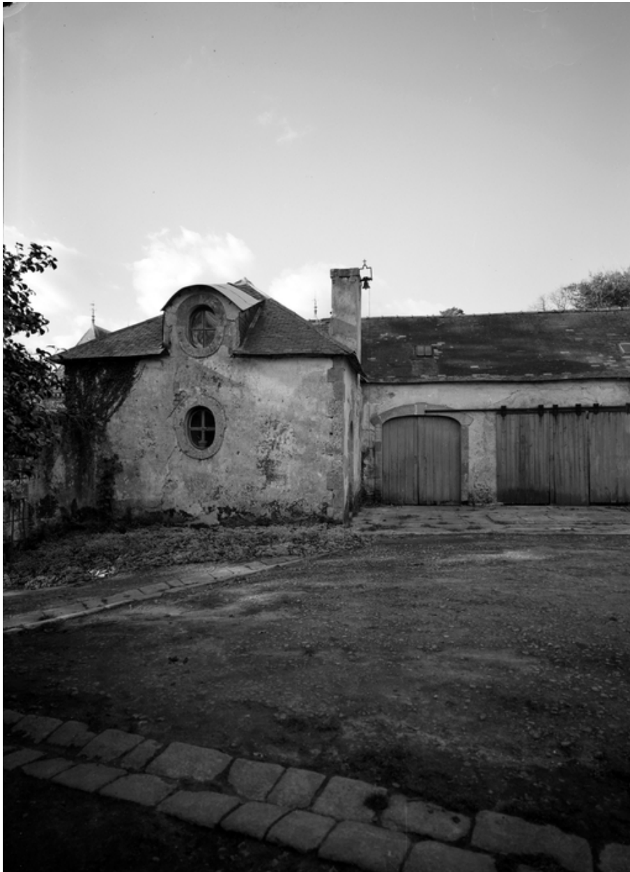
Communs : vue de la partie nord-ouest
