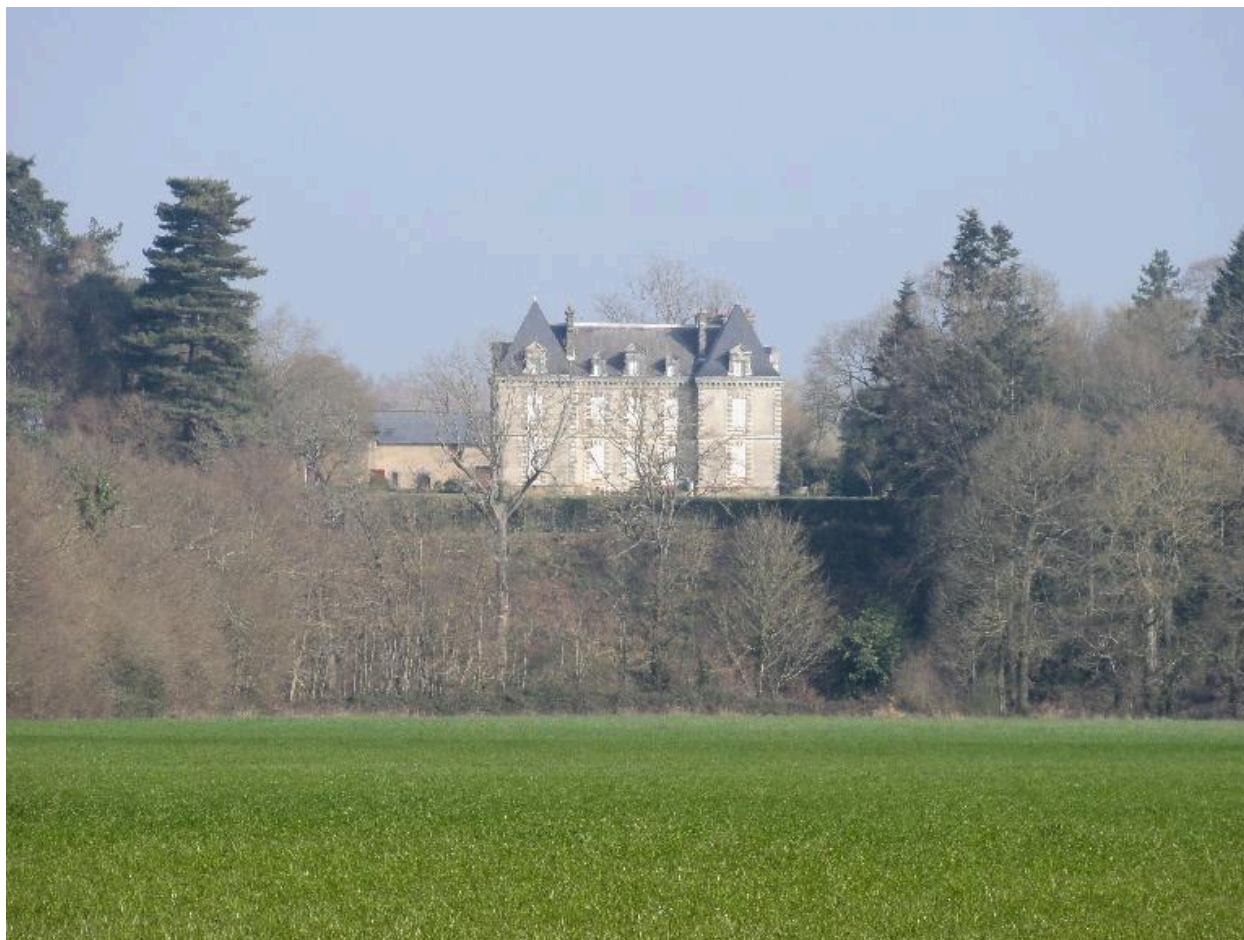
Château : élévation sud (état en 2011)
