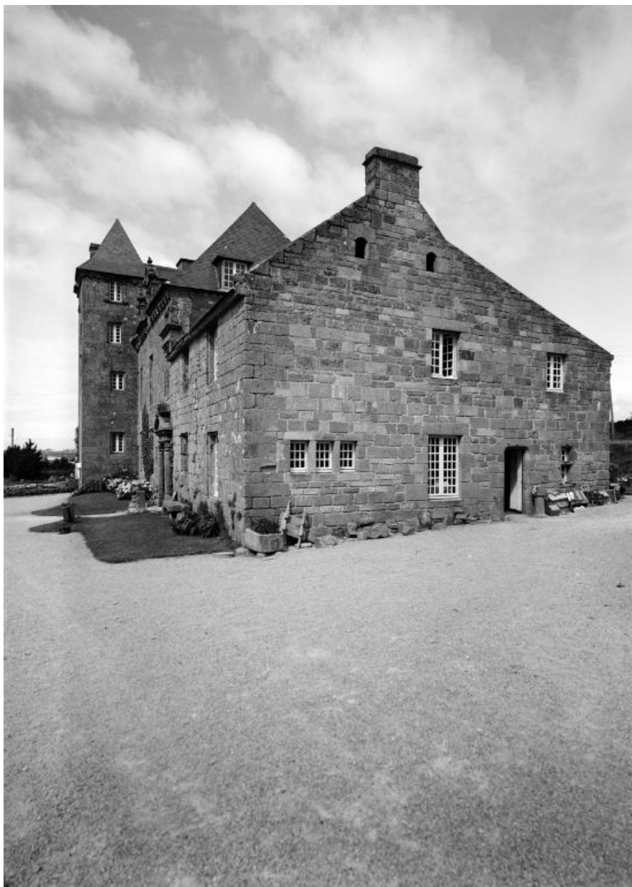
Vue d'ensemble du pignon est
