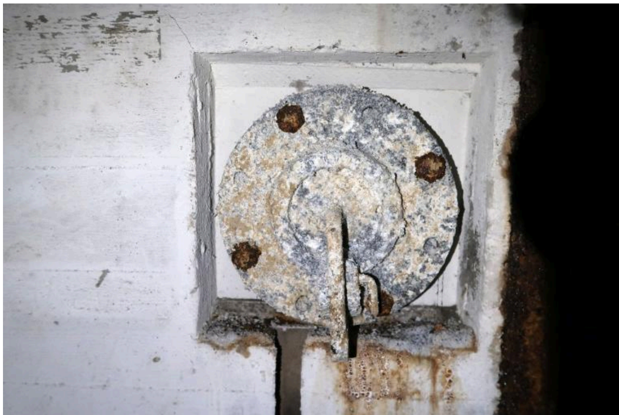
Vue intérieure : salle de garde sud, bouche de surpression à clapet à contrepoids en aluminium
