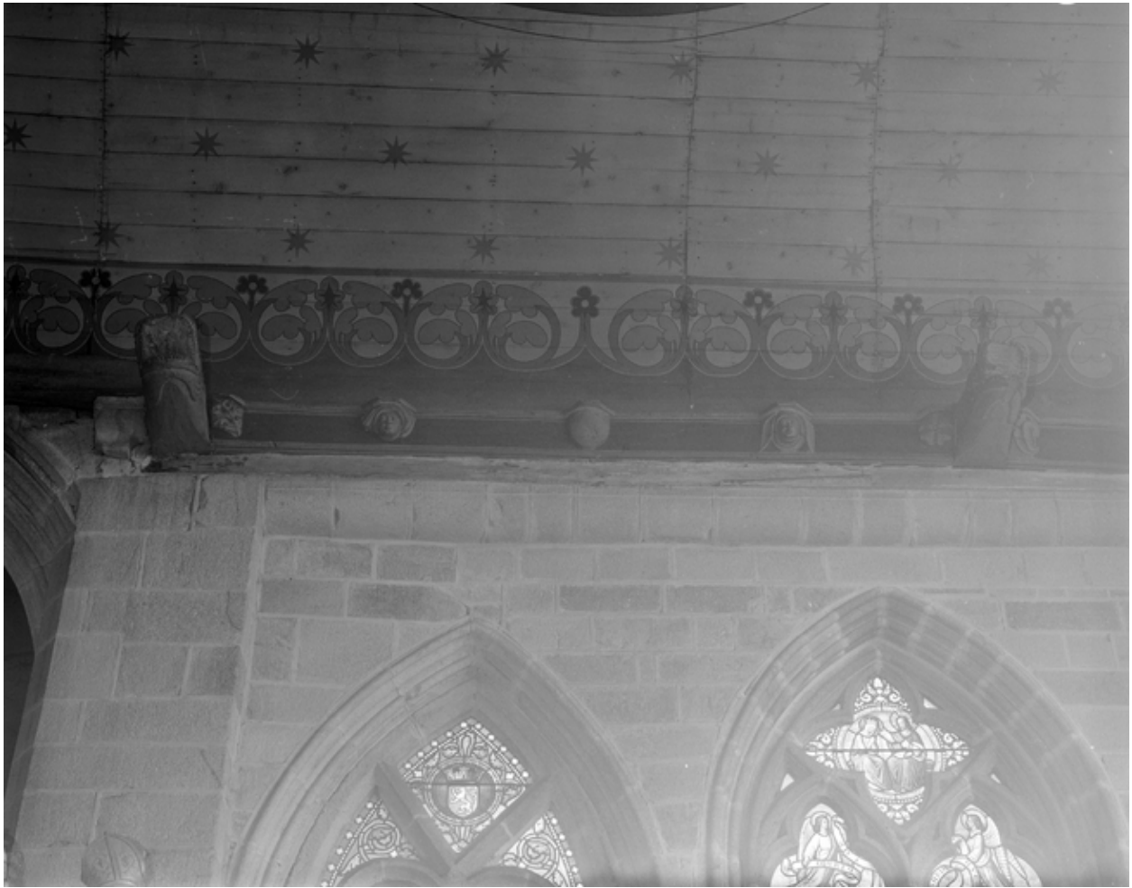
Sablière n°6, bras sud, mur est, partie gauche
