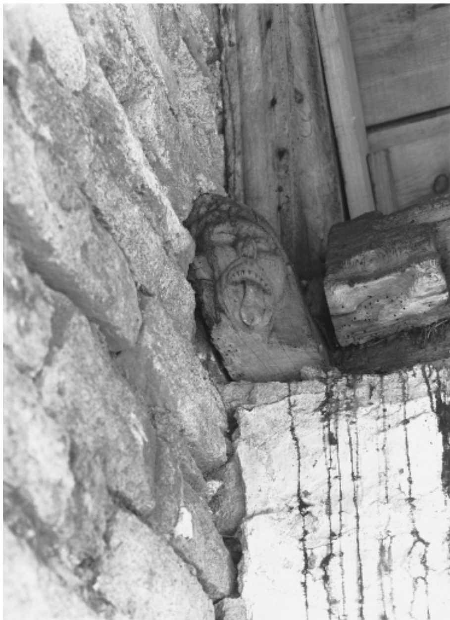
Angle sud est : détail du blochet
