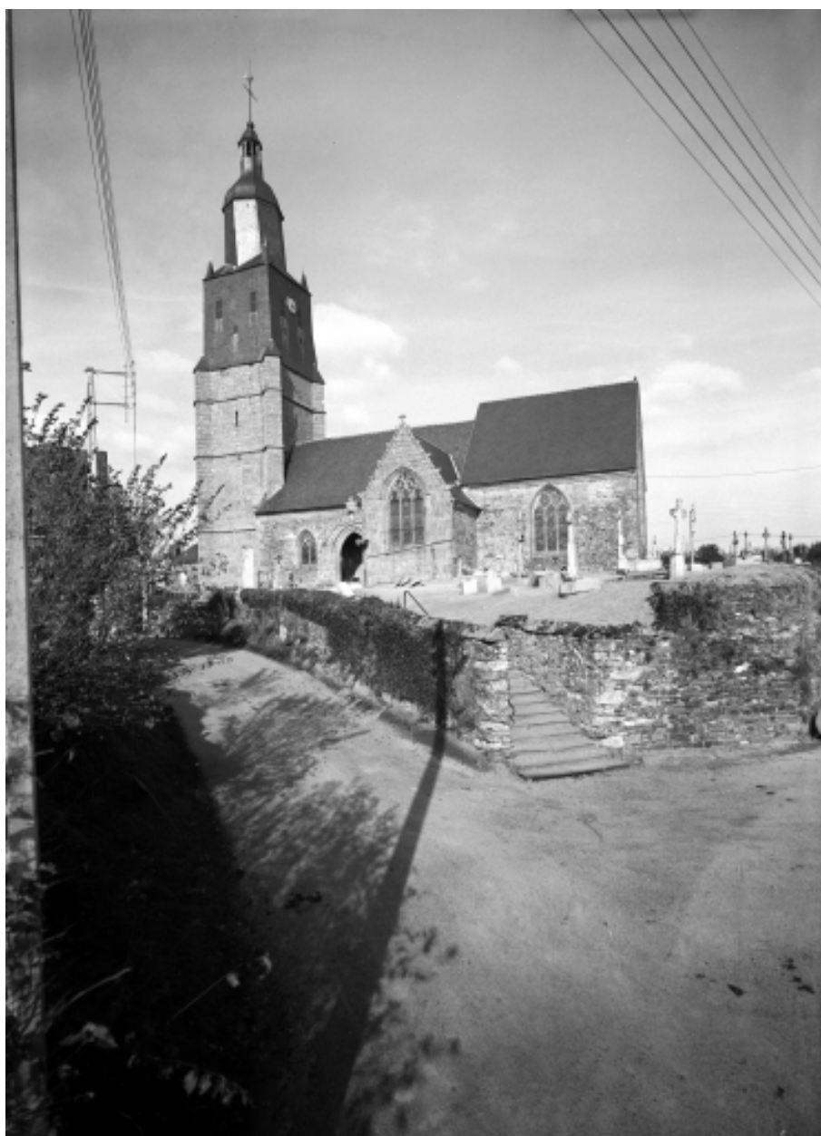
Elévation sud : vue générale
