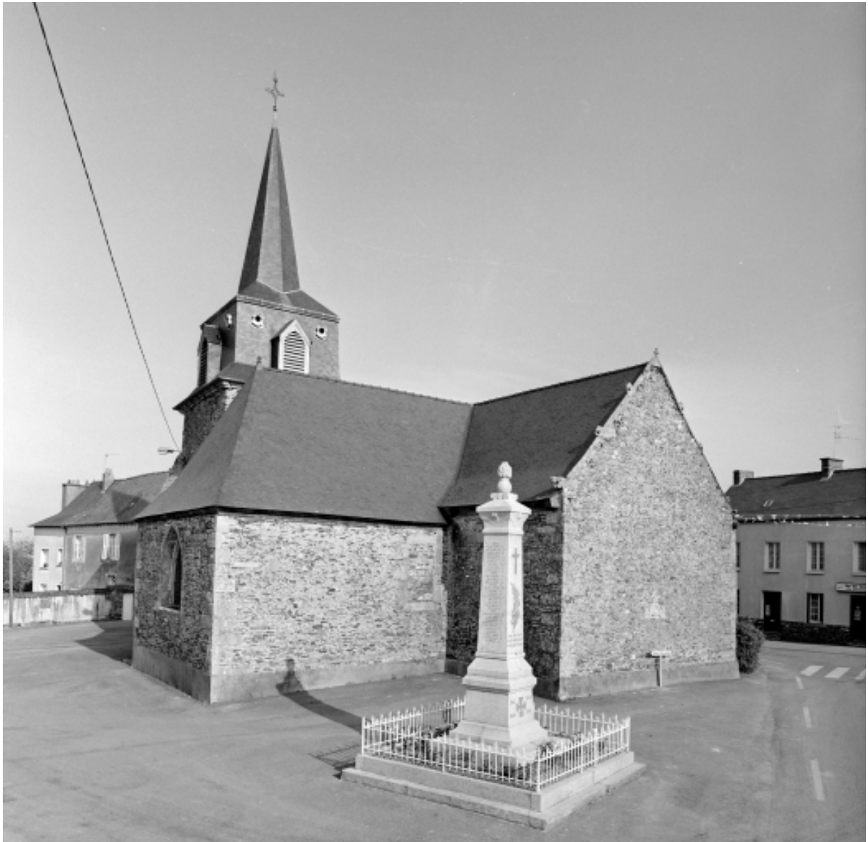
Elévation Est : vue générale
