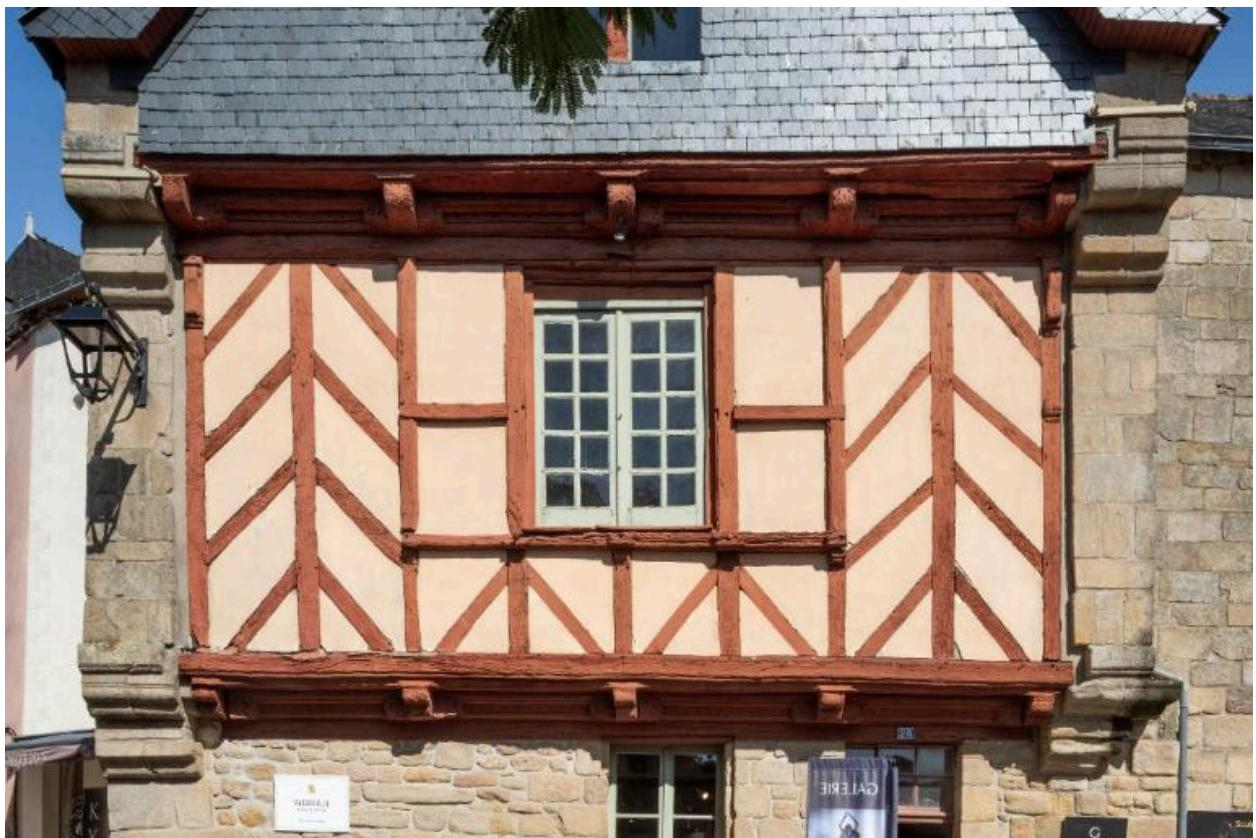
Contreventement de l'étage en chevrons avec initialement quatre travées centrales destinées aux fenêtres.
