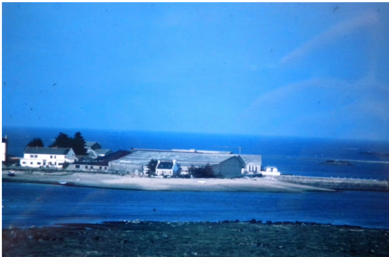
Vue des bâtiments de l'ancienne usine avant démolition, vers 1980
