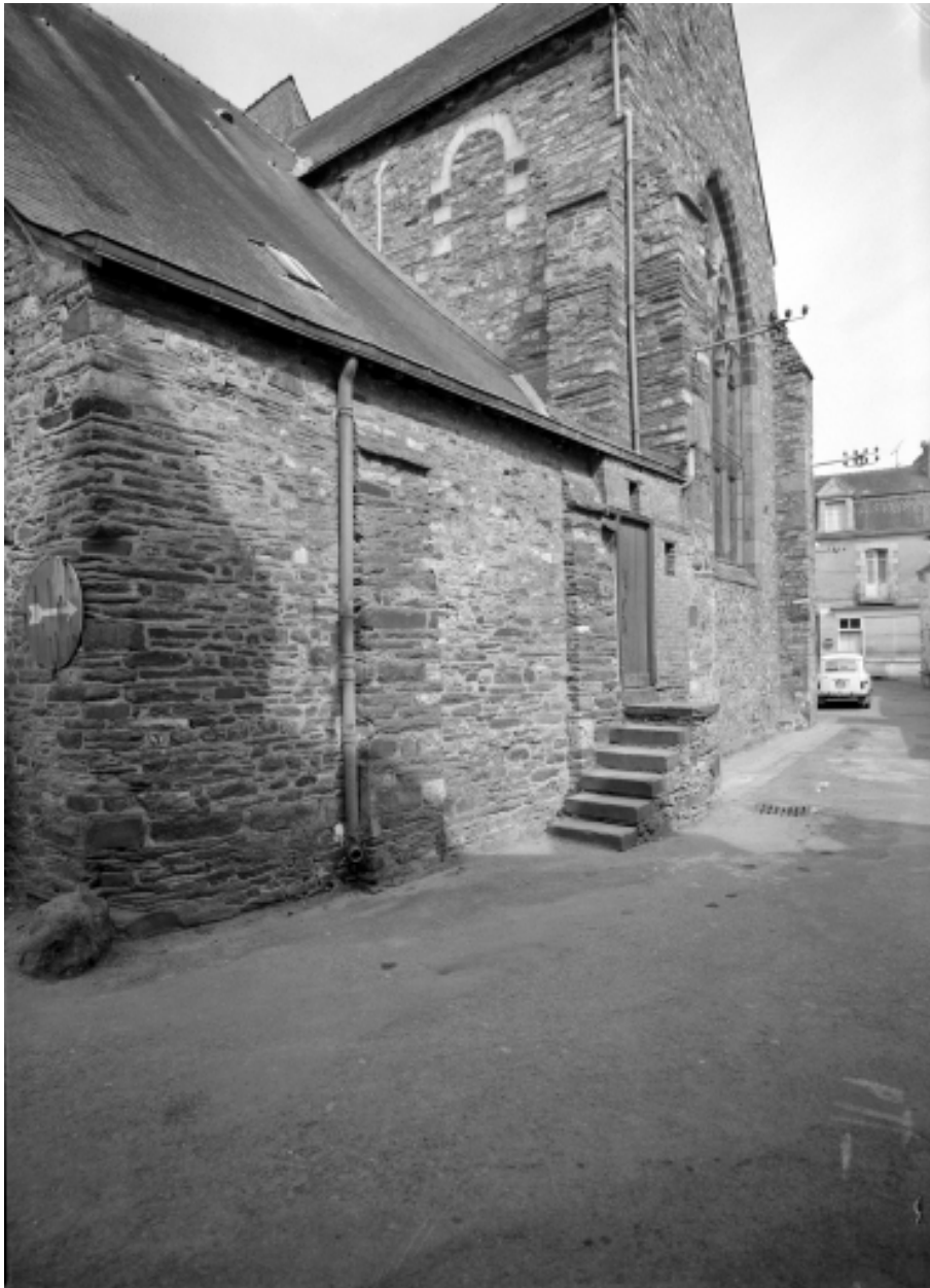
Elévation sud-est, chevet : vue générale
