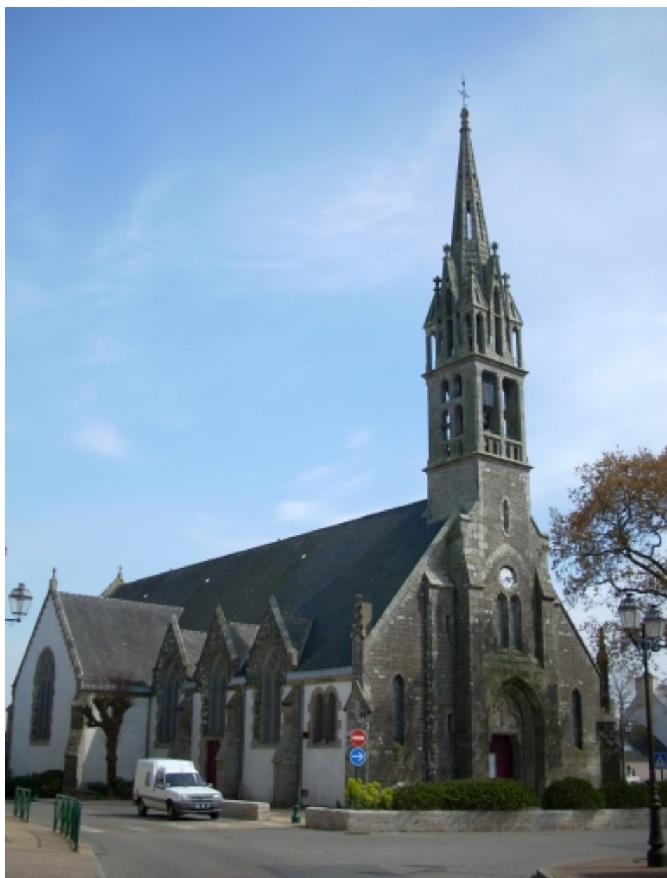
Concarneau, Beuzec-Conq, église Saint-Budoc : vue générale nord-ouest
