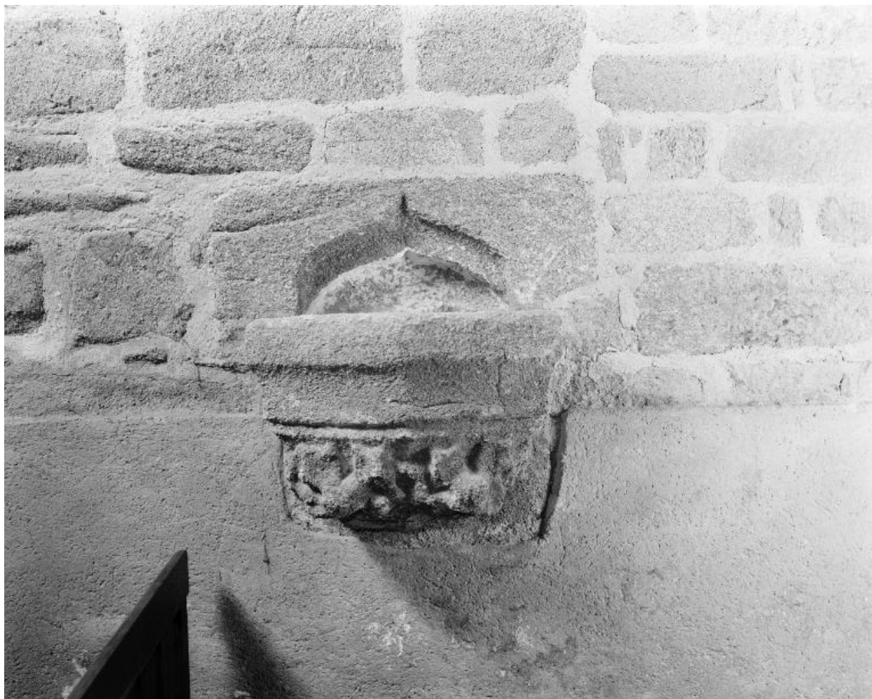
Mur sud, détail du bénitier.
