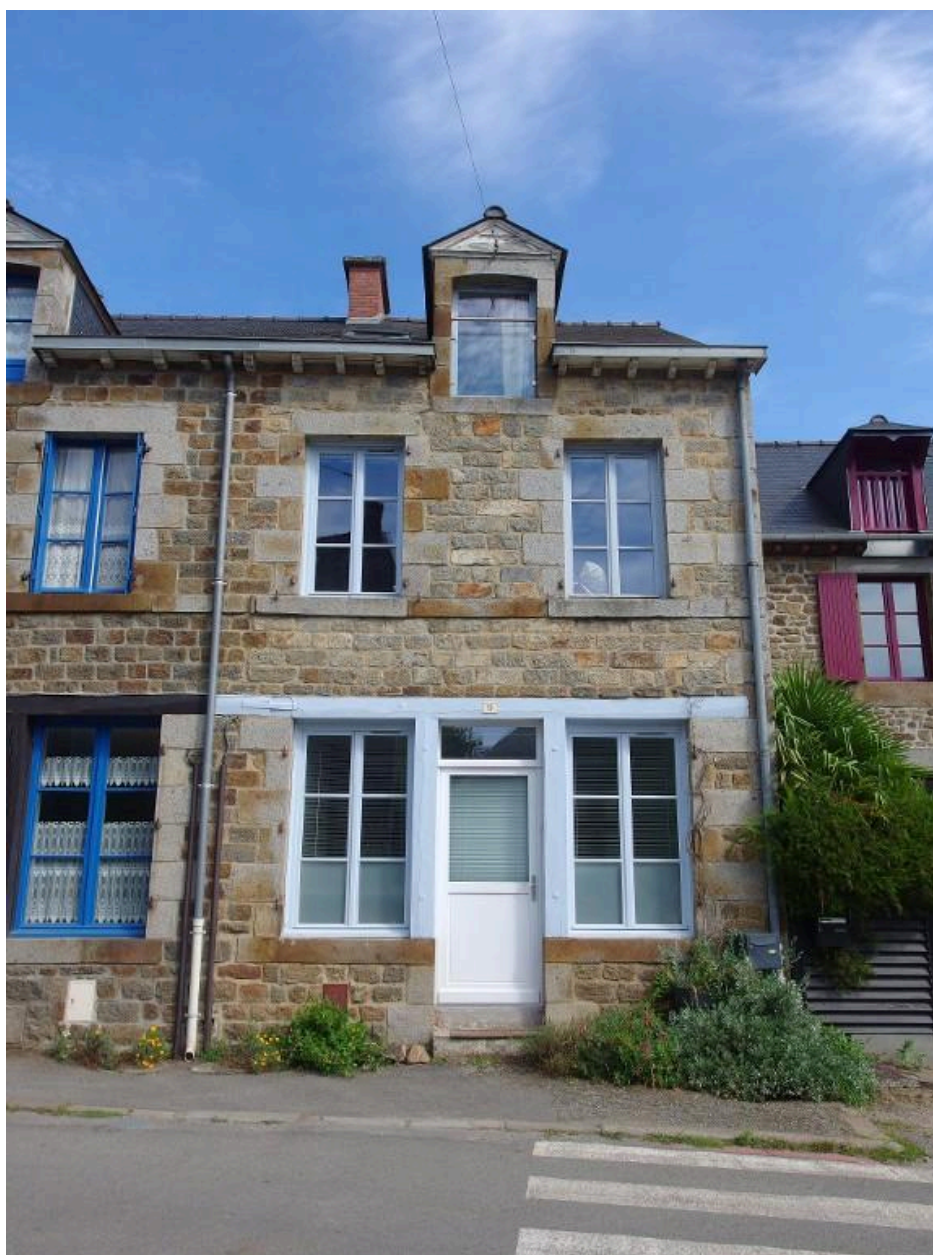
Vue de la façade sud
