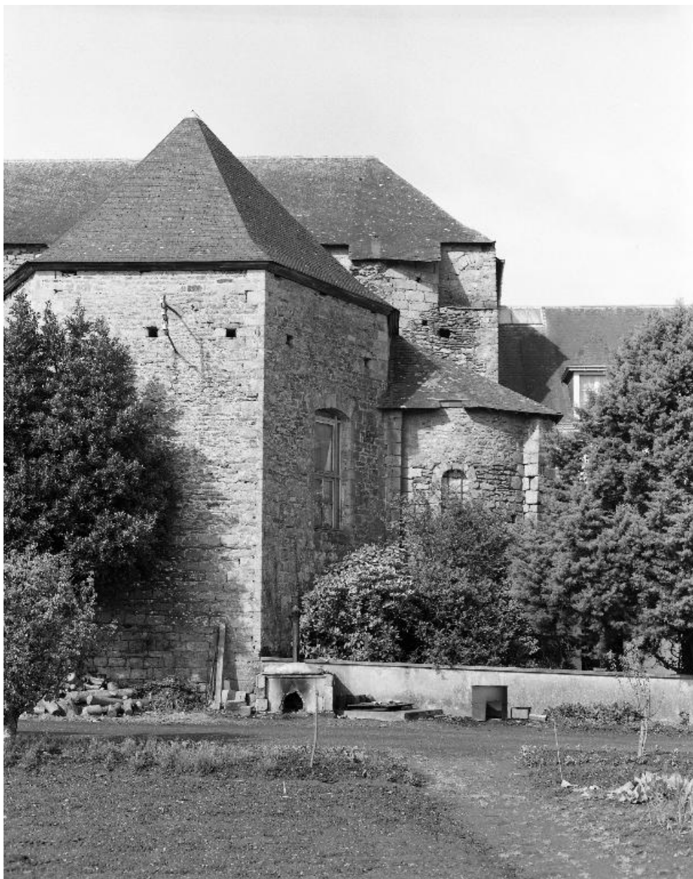
Église, élévation est : partie nord (état en 1994)
