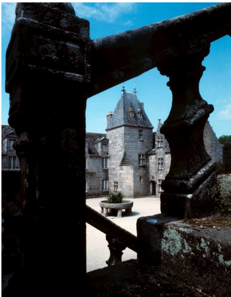
Logis, tour d'angle et balustrades de l'escalier
