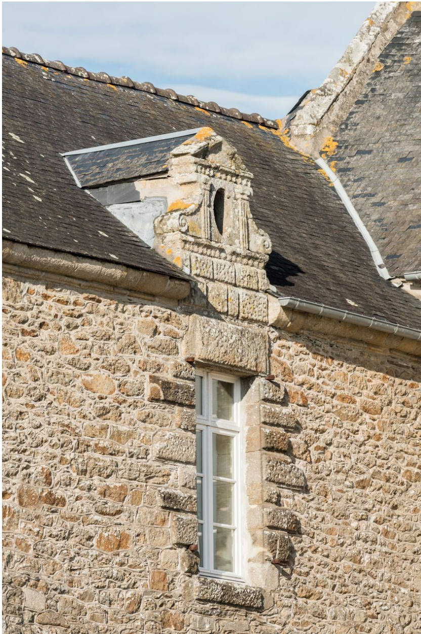
Détail d'une lucarne ornée de pilastres et volutes, coiffée d'un fronton triangulaire
