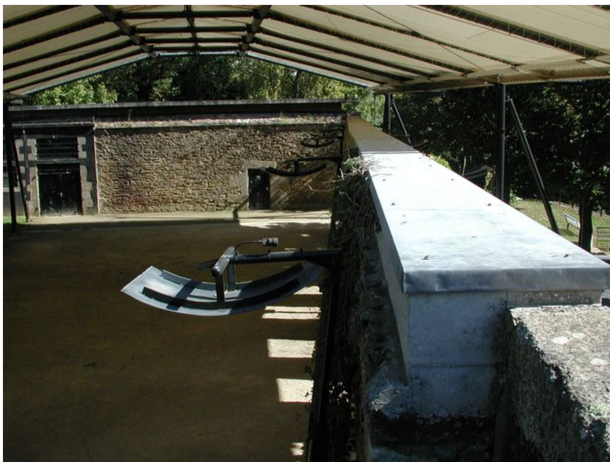
Vue du fort du Dellec : structure légère et toile assurant le couvert de l'espace de la caserne aujourd'hui réhabilité. Apperçu des travaux d'étanchéité des maçonnerie
