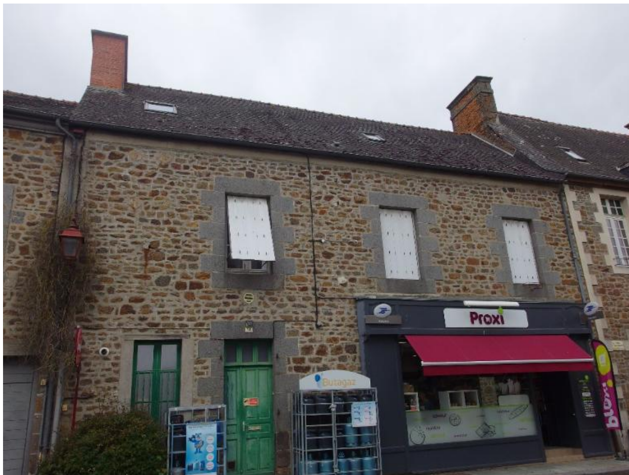
Vue de la façade est
