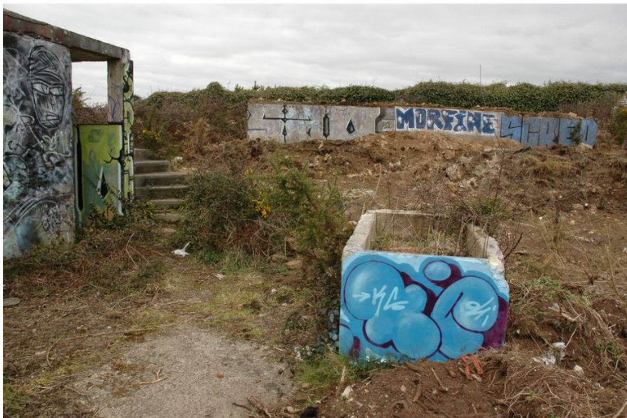
Vue de situation au niveau de l'abri à munitions de sûreté : lavoir (état en 2005à
