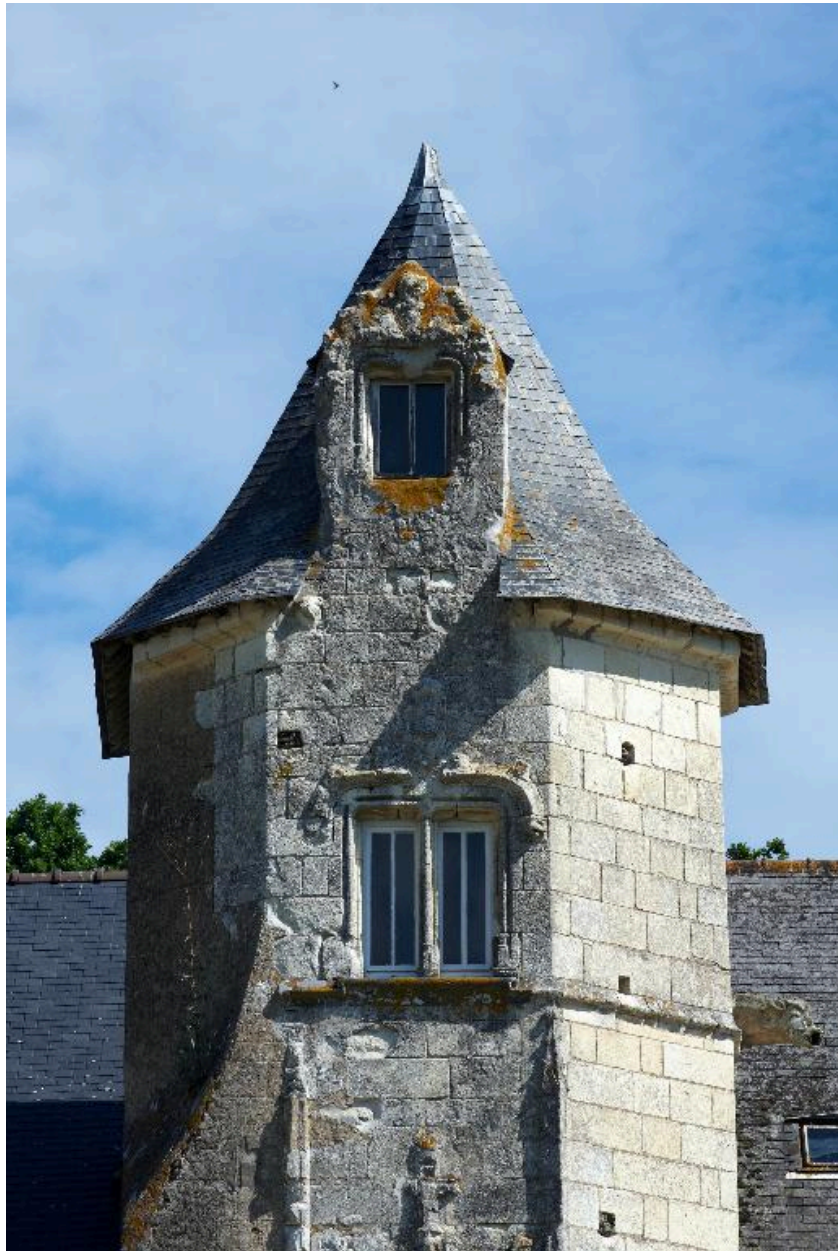
Partie supérieure de la tour d'escalier
