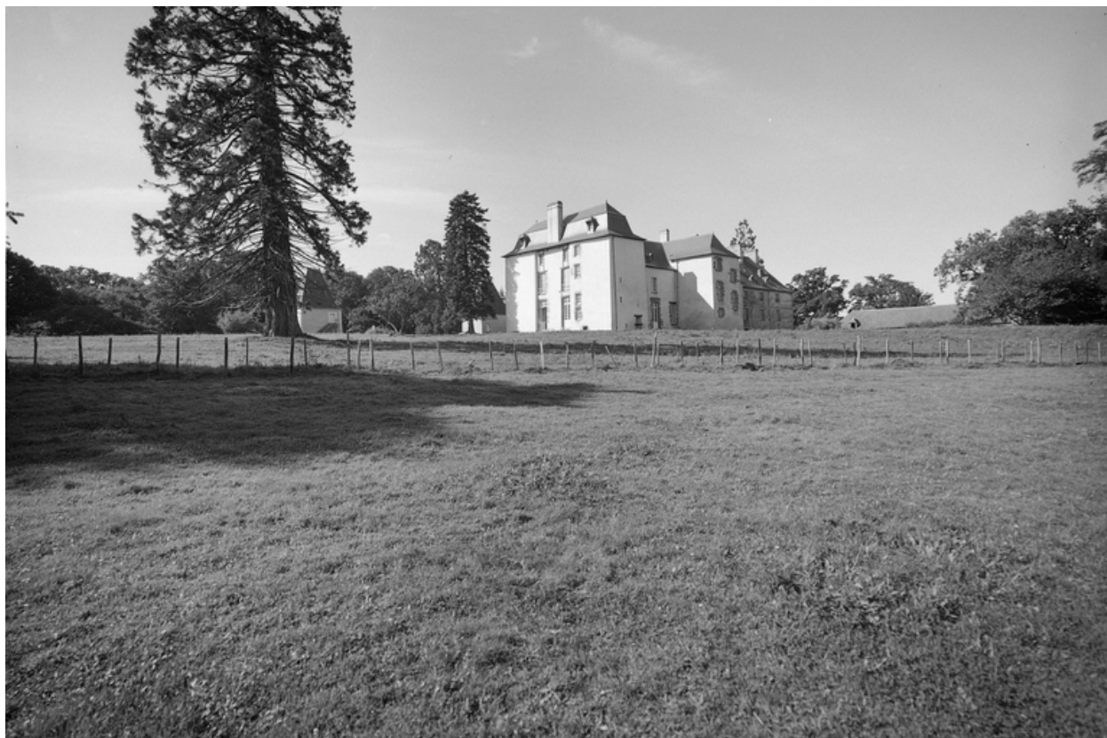
Vue de situation, prise du nord-est.
