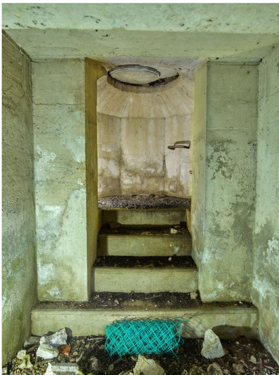
Vue intérieure (une mince dalle de béton protège le poste d'observation et de tir circulaire des risques de chute)
