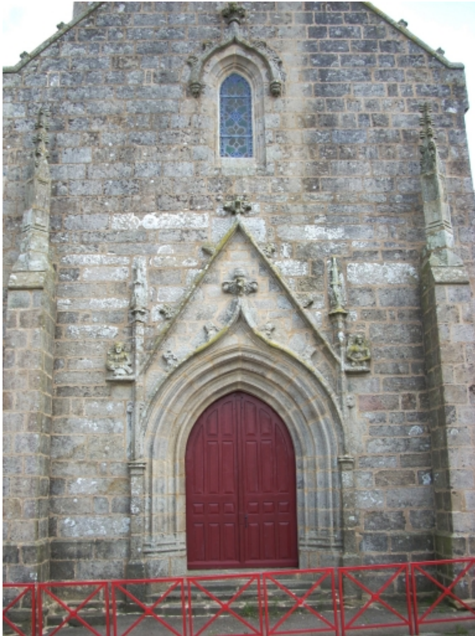
Landudec, église paroissiale Saint-Tudec et Sainte-Anne : détail, porte ouest
