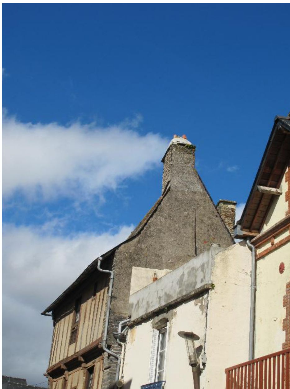
Pignon sud-est vu depuis la rue du Général de Gaulle (état en 2012)
