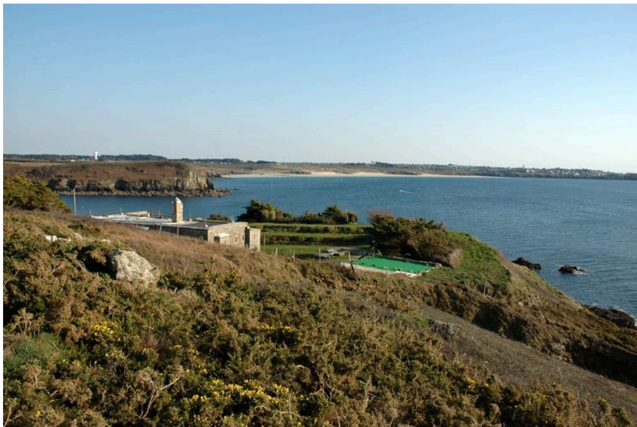
Vue de la pointe d'Illien nord depuis le sentier côtier : batterie d'artillerie de côte et corps de garde crénelé (état en 2006)
