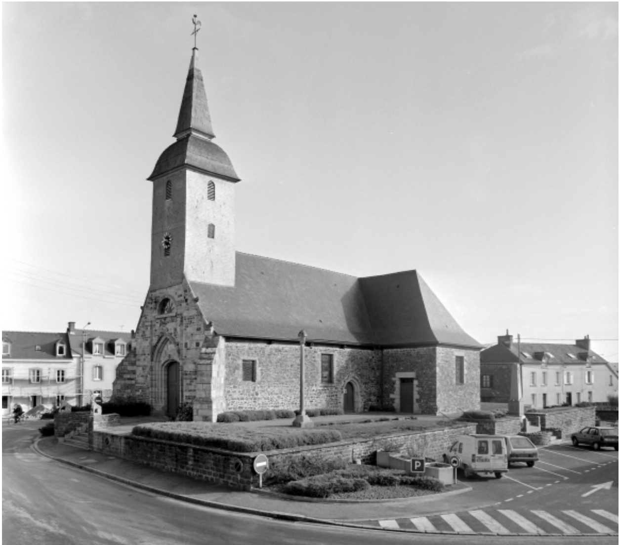
Vue générale du sud
