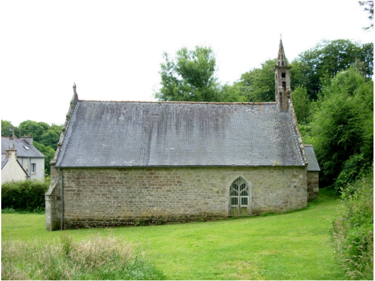
Bohars, chapelle de Loguillo : élévation nord
