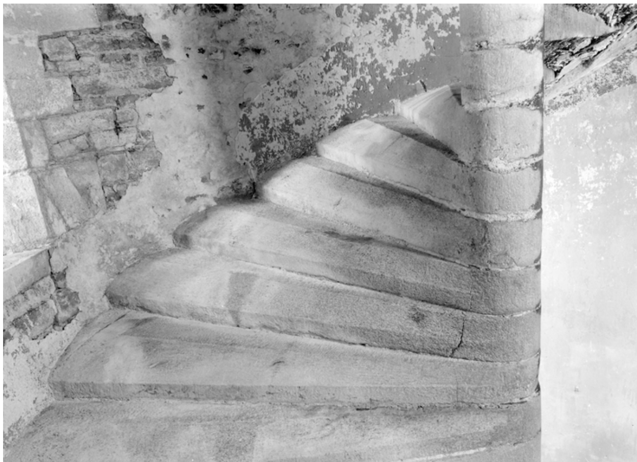
Etage, escalier : vue prise du palier.
