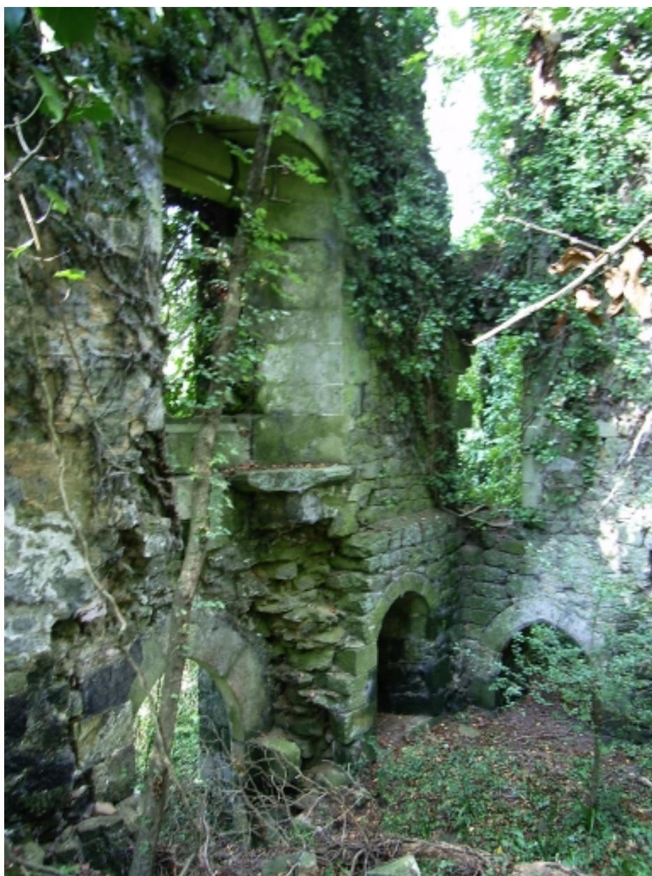
Château de la Touche-à-la-Vache, vue intérieure du donjon
