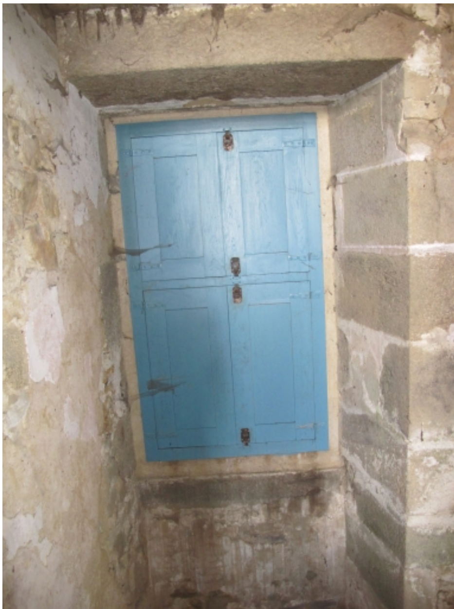
Fenêtre située dans la montée de l'escalier
