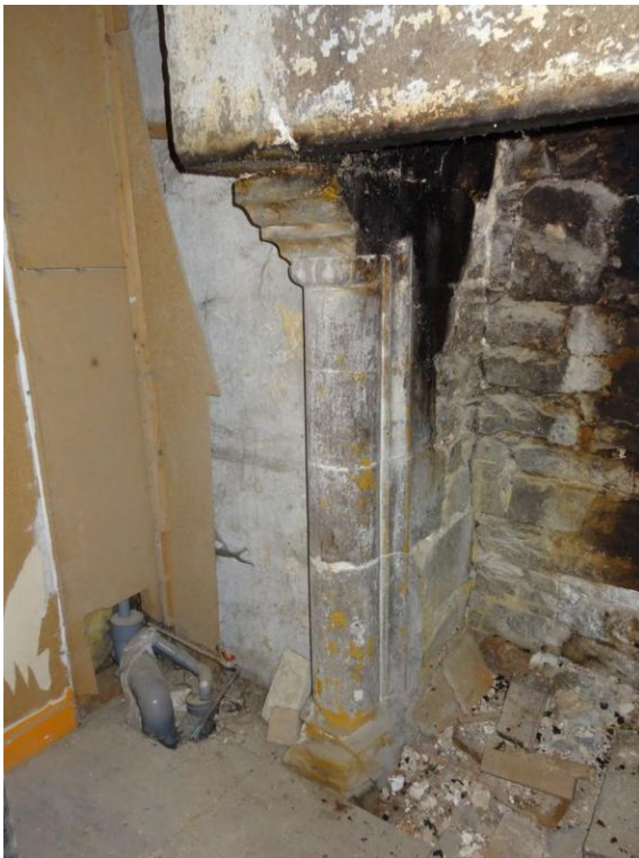
Piédroit de la cheminée de la pièce sud du premier étage
