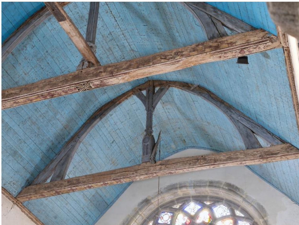
Charpente de la nef, vue des deux fermes proches du chevet
